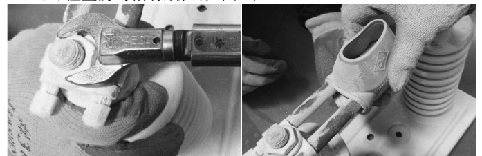
图1 检查电容器桩头的接线情况
