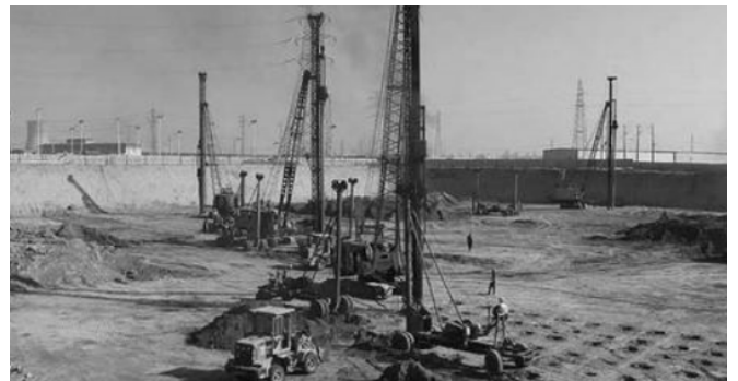
图1 素土机密桩控制技术
