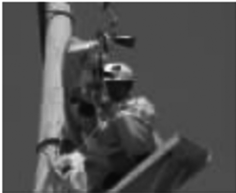
图 1 带电作业现场
